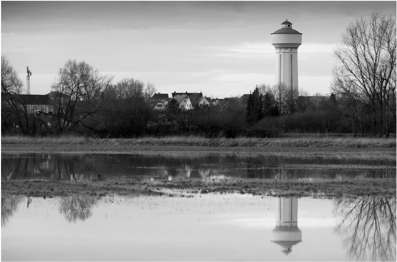
Château d'eau de Bischwiller. Photographie d'Alfred Dott.
