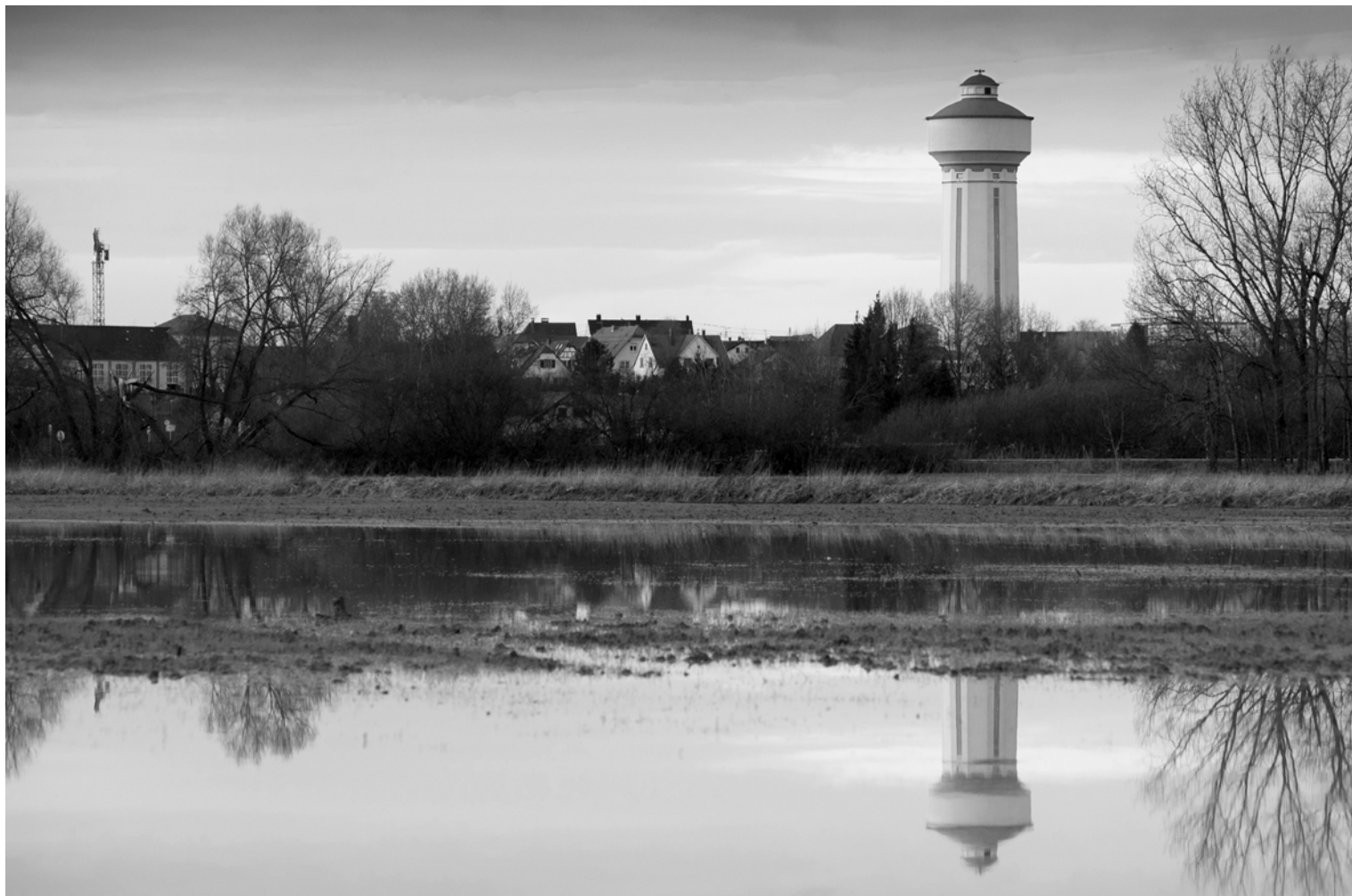
Château d'eau de Bischwiller. Photographie d'Alfred Dott.
